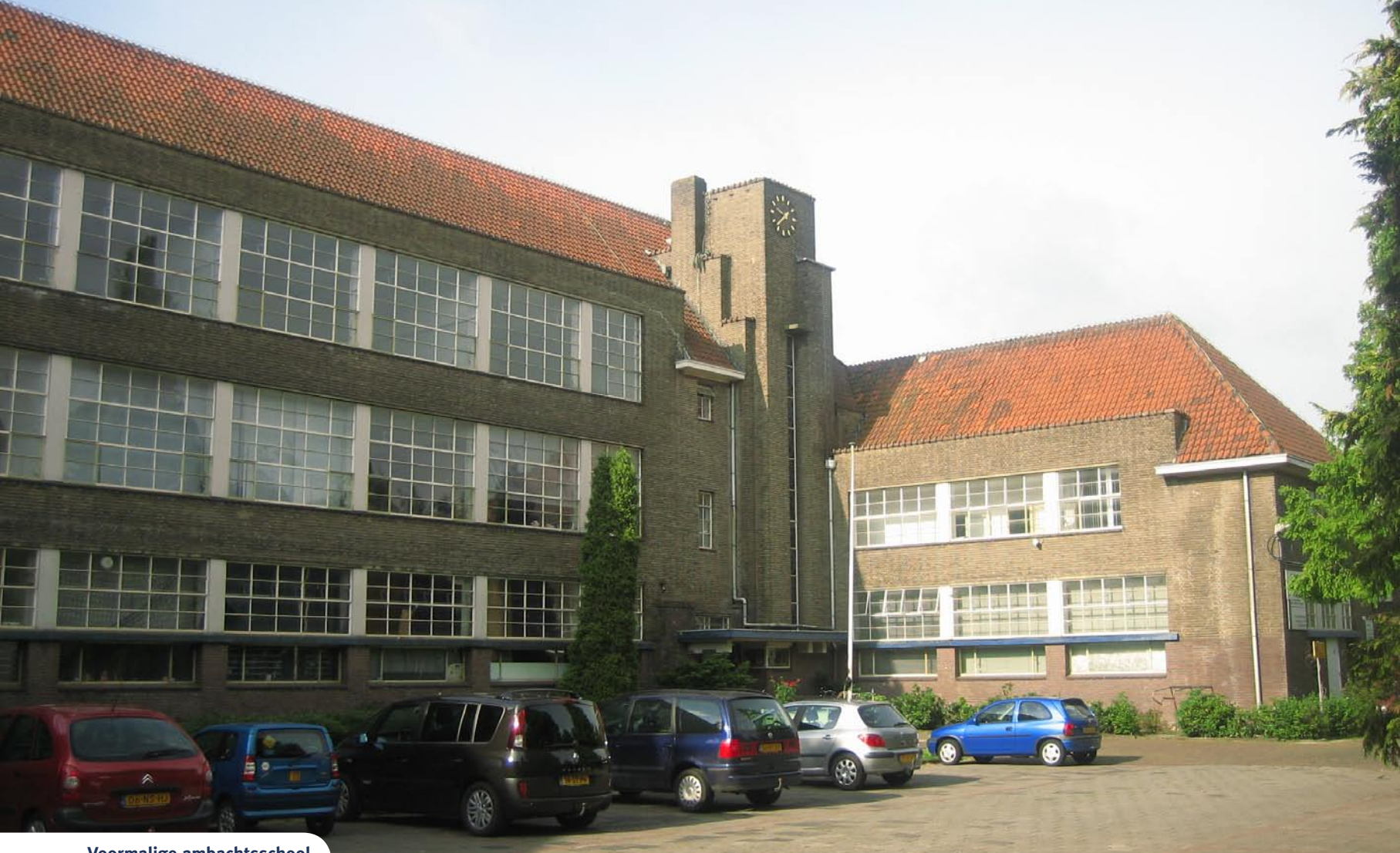
Voormalige ambachtsschool aan de Graaf Florisweg, in afwachting van een nieuwe functie (foto Marije Strating)
