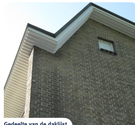
Gedeelte van de daklijst
