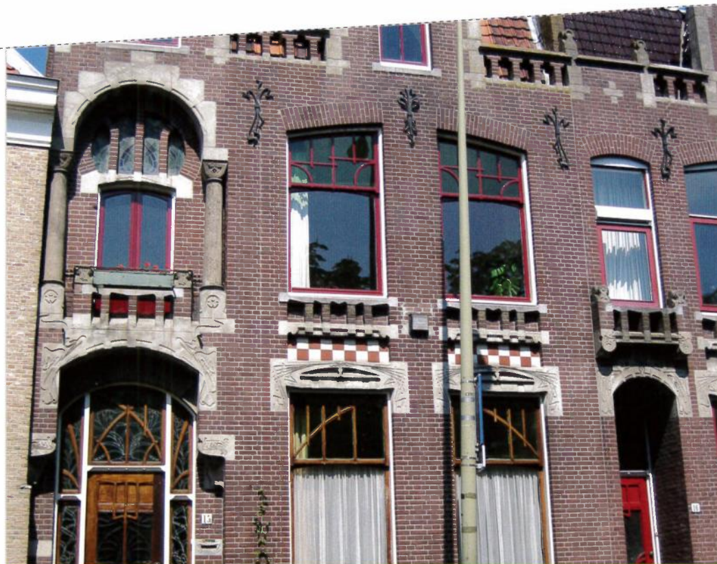
Gevel Blekerssingel 15-16 van H. J. Nederhorst, 1900. Bijzondere deurpartij met karakteristieke hoefijzerboog op de eerste verdieping.
